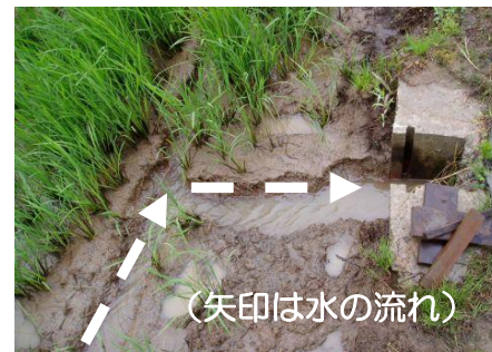
【溝の末端を排水口に接続した状態】
